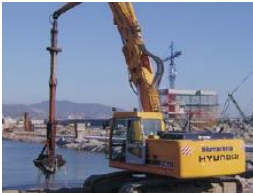
Foto 1. Equipo perforando en zona portuaria
